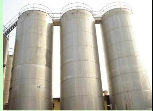
New 150 KL Silo
